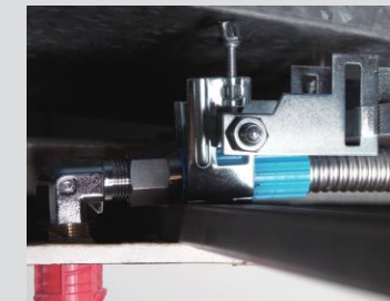
ダクト下用金具施工例
