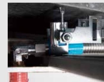
ダクト下用金具施工例
